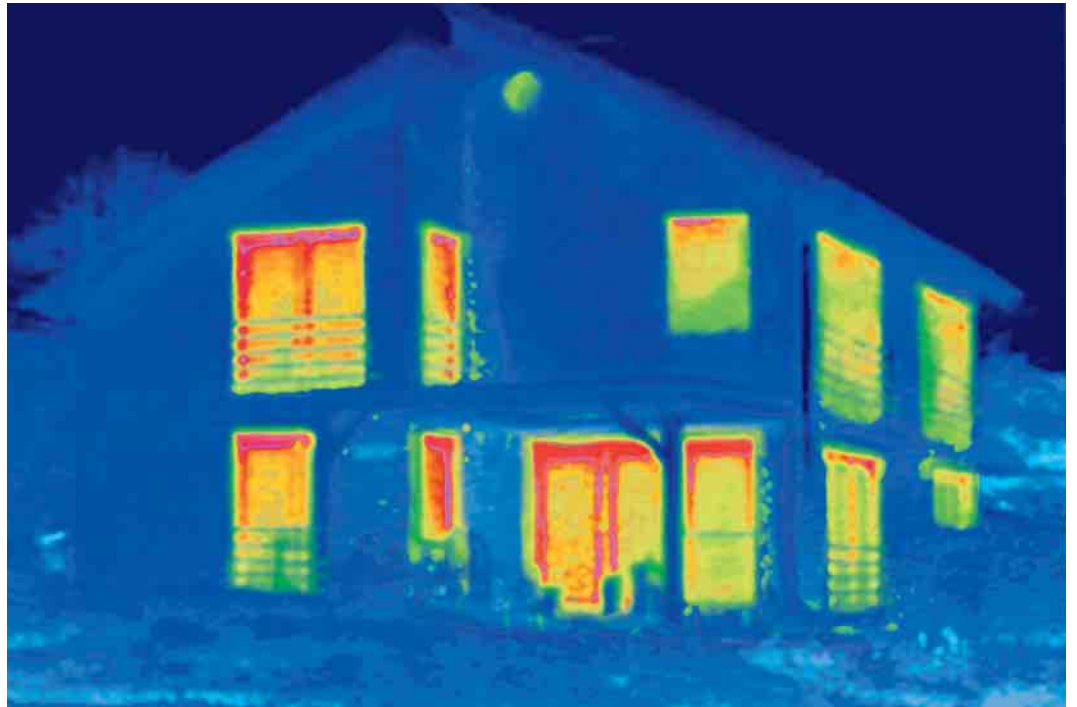
Thermografie vor dem Einbau neuer Schüco Thermo 6 Classic Energiesparfenster
