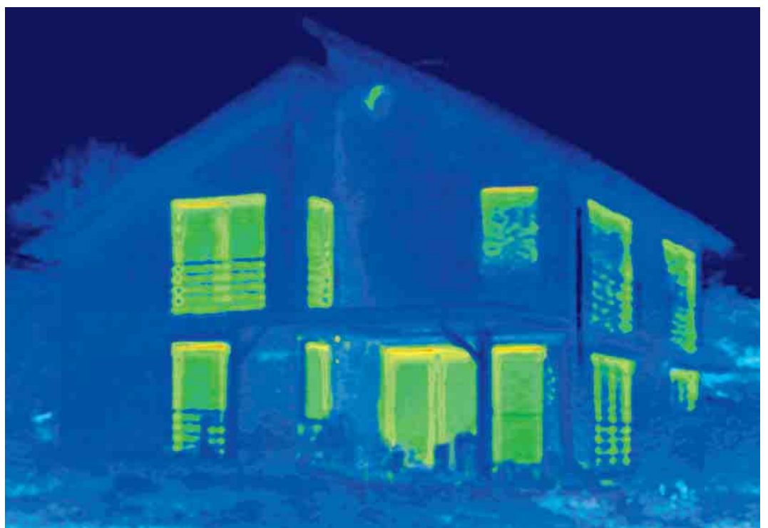
Thermografie nach dem Einbau neuer Schüco Thermo 6 Classic Energiesparfenster
