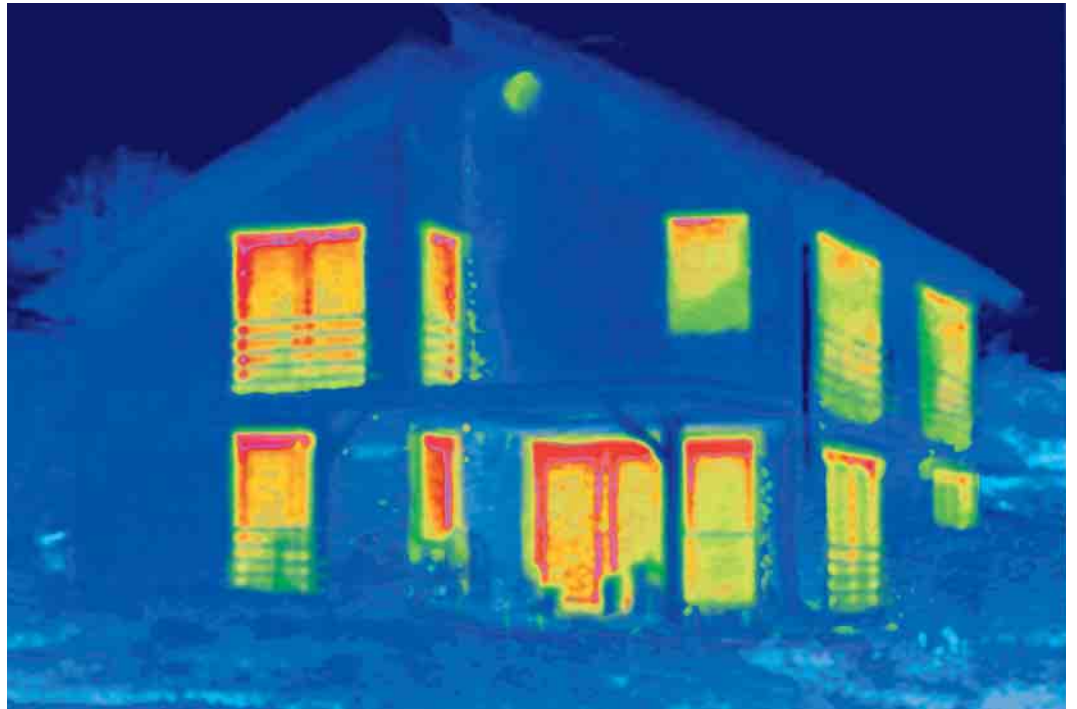
Thermografie vor dem Einbau neuer Schüco Thermo 6 Cava Energiesparfenster
